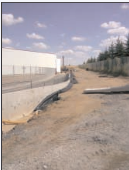
Erschließungsstraße zum Standort Nitzschka Teilgebiet III
