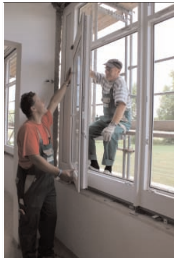
Klaus Pohl (rechts) und Mario von Bergen von der Tischlerei Bellmann GmbH Schmölln beim Einbau neuer Fenster an der Landschule Treben
