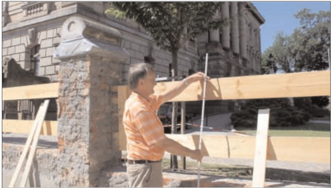
Der Chef der Löber Bau GmbH in Thonhausen Wolfgang Löber bei Messarbeiten
