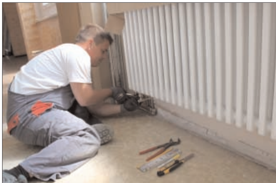
Jens Kämpfer von der Firma Baum & Schirmer aus Meuselwitz beim Einbau neuer Heizkörper an der Landschule Treben
