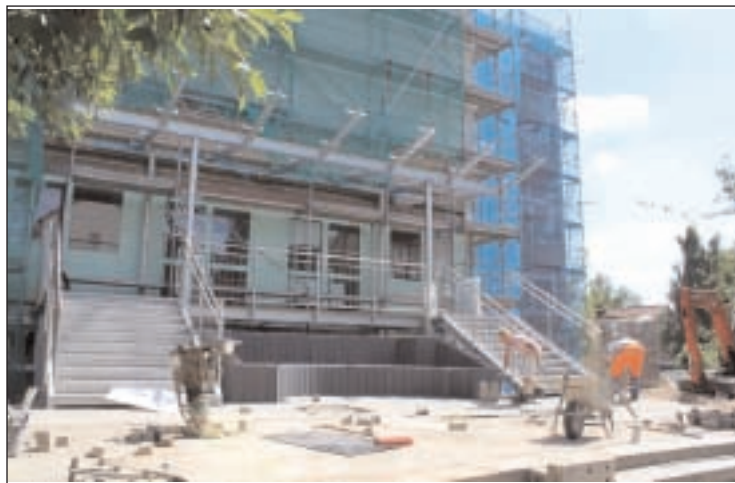
René Langmesser und René Wähler von der Firma Gerth Tief- und Pflasterbau GmbH Nitzschka bei den Arbeiten an der neuen Eingangstreppe zum Schulgebäude Helmholtzstraße des Roman-Herzog-Gymnasiums in Schmölln
