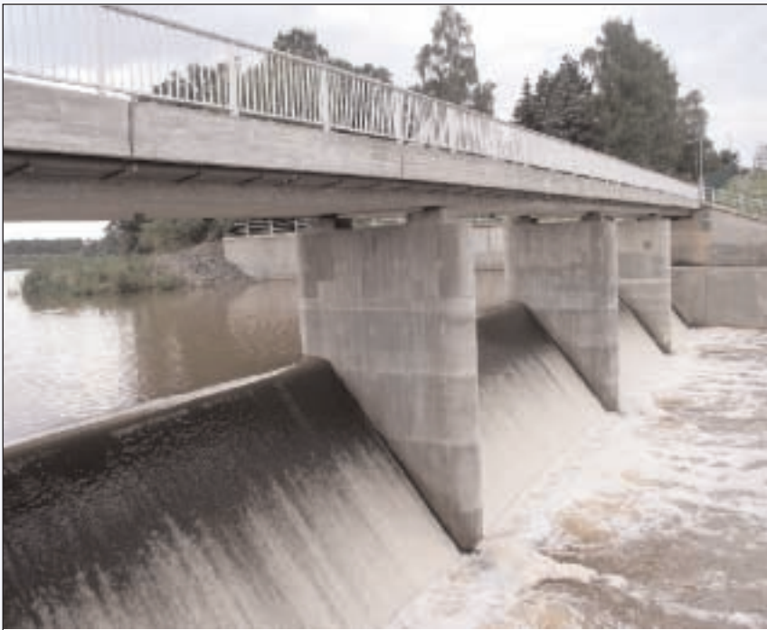
Die Talsperre Windischleuba nach Fertigstellung der Sanierung im Jahr 2010
