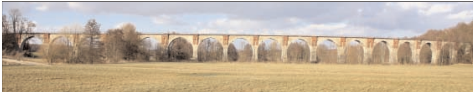
Der 330 Meter lange Wiesebachviadukt gilt als Europas "größte Eisenbahnbrücke mit der intensivsten Krümmung"
