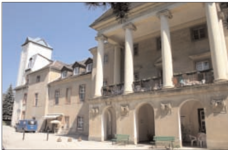
Das Eingangsportal nach der Sanierung (oben) und davor
