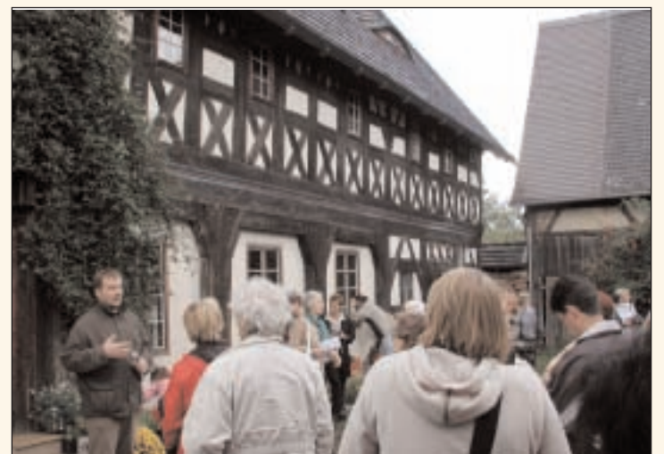
Der Hof „Schramm“ öffnete schon mehrfach am Denkmaltag seine Pforten. Hier erläutert Bauforscher Lutz Scherf das Besondere der Bauweise des Umgebendehauses.
