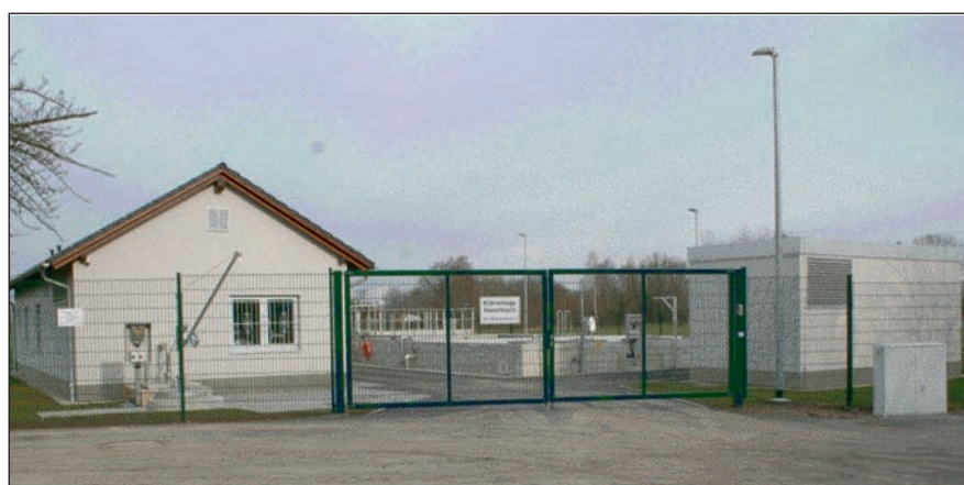
Zum Weltwassertag am 22. März können interessierte Bürger u. a. die vom Zweckverband Wasserversorgung und Abwasserentsorgung Altenburger Land errichtete Kläranlage in Haselbach besichtigen Foto: Thomas Wesser
