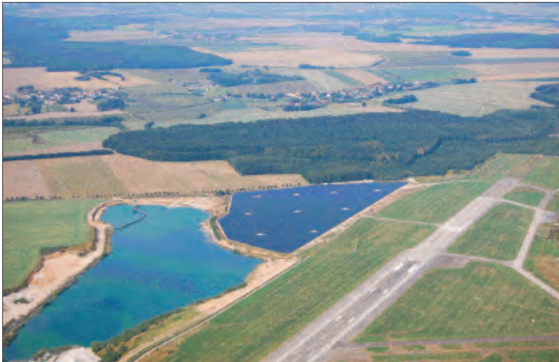
Blick auf den Solarpark des Flugplatzes, der an die Nobitzer Kiesgrube grenzt.
