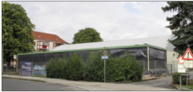
An der Turnhalle des Roman-Herzog-Gymnasiums in Schmölln werden gegenwärtig die Fassadenelemente erneuert
