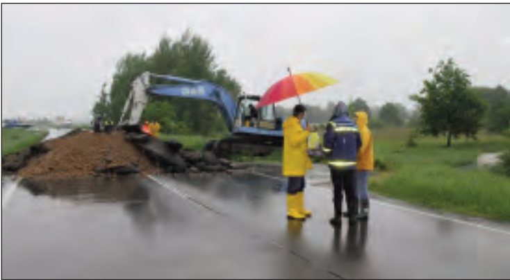
Wie bereits im Jahr 2002 wurde die Bundesstraße 93 bei Treben aufgebaggert, um die Ortslage Serbitz vor übermäßiger Überflutung zu schützen
