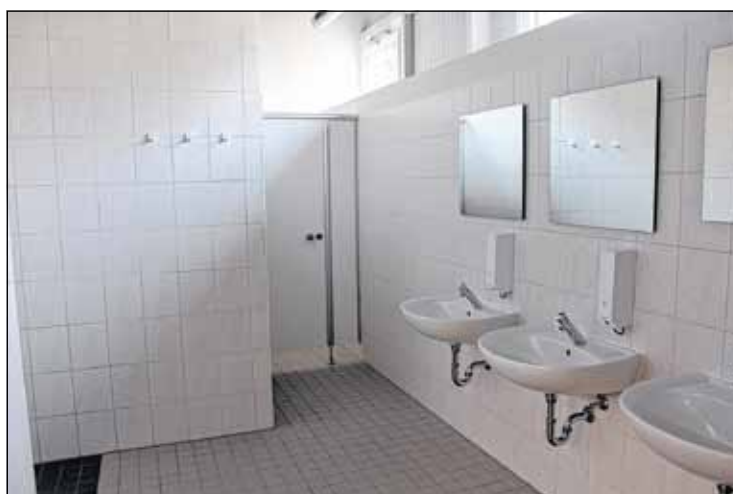
Auch die Sanitär- und Duschanlagen wurden in einem zweiten Bauabschnitt umfassend saniert
