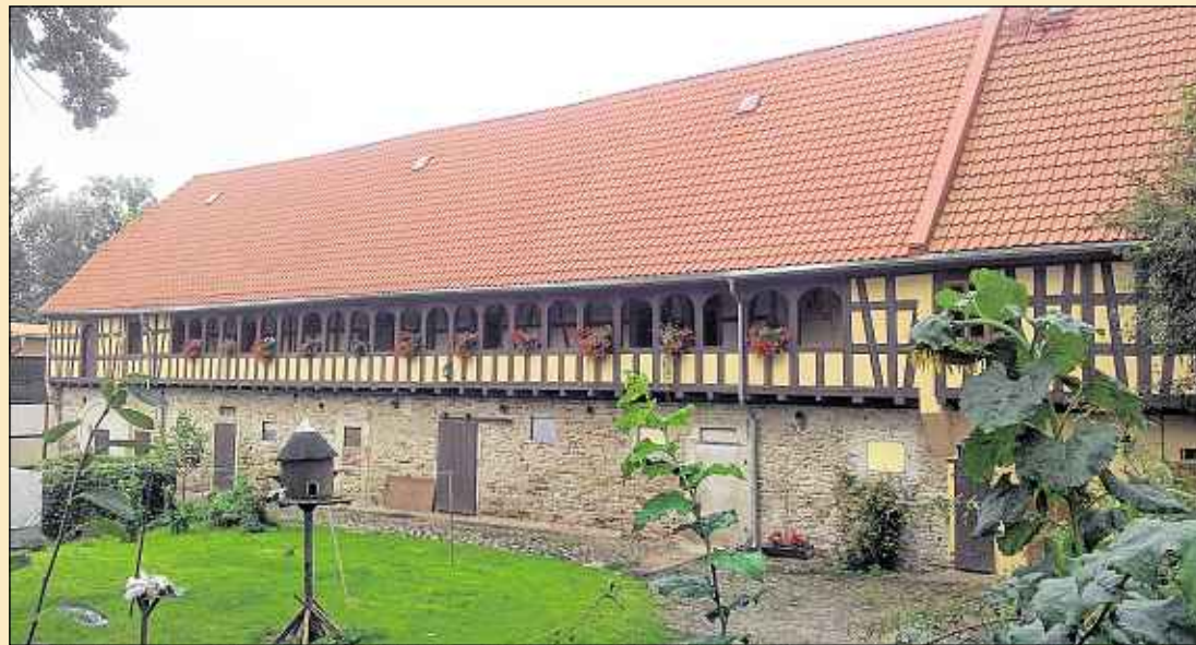
Das Laubenganggebäude des ehemaligen Rittergutes in Schwanditz: Mit der Fertigstellung der Dacheindeckung ist ein wesentlicher Schritt für die weitere Nutzbarmachung des Gebäudes getan
