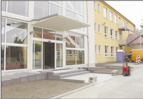
Erneuert: Die Treppenanlage des Lerchenberggymnasiums
