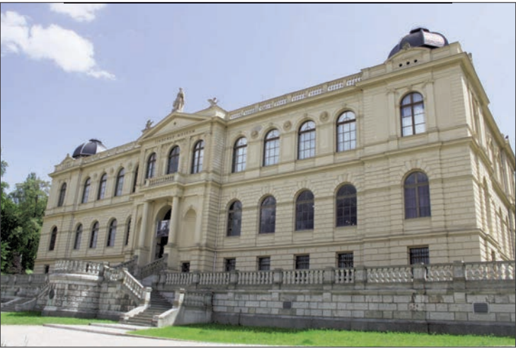
Zehn Millionen Euro sollen bis 2022 ins Lindenau-Museum investiert werden. Mitte Mai hat der Kreistag zudem den Grundsatzbeschluss gefasst, perspektivisch Depots, Büros und Werkstätten in den Marstall auszulagern
