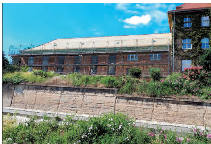
Über eine Million Euro fließt in die Sanierung der Schulturnhalle.
