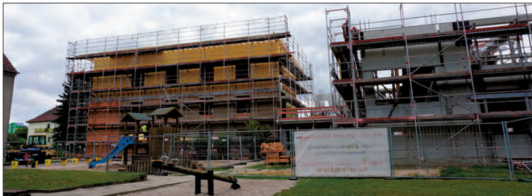
Die neue alte Schule in Nobitz nimmt mehr und mehr Gestalt an. Das linke Gebäude wird saniert, das rechte ist ein kompletter Neubau.
