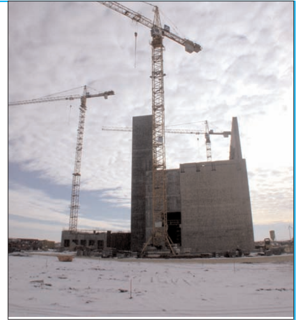
Fernansicht: Sita-Baustelle in Zorbau
