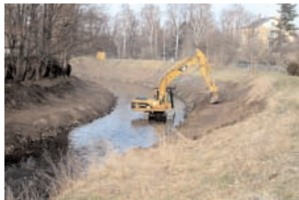
Aufweitung des Hochwasserabflussprofils der Pleiße
