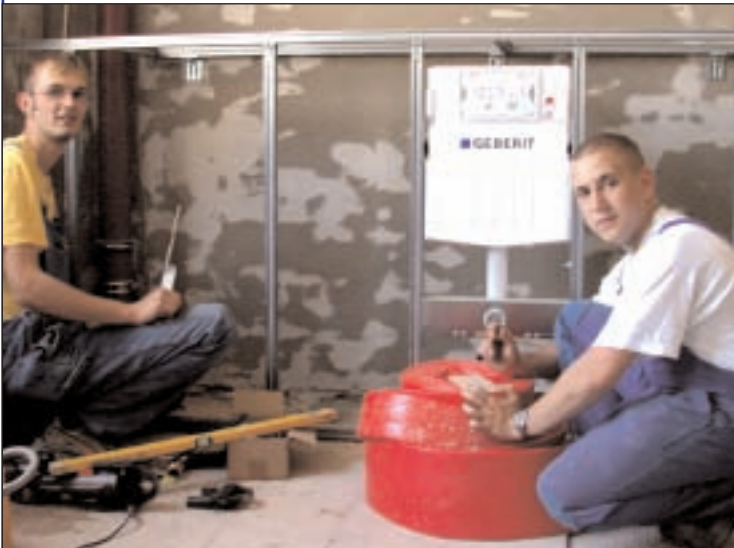
Die zukünftige Grundschule Wintersdorf bekommt unter anderem neue Sanitäreinrichtungen: Peter Franke (l.) und Christian Fiedler bauen sie ein.
