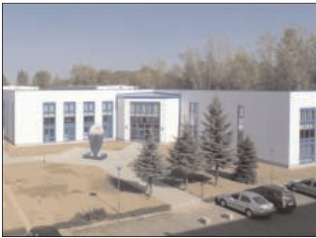
MBZ Gebäude in Meuselwitz
