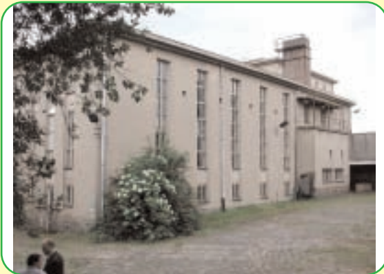
Die EWA GmbH bietet im "Wasserwerk Pleißenaue" die einmalige Chance eines Einblicks.
