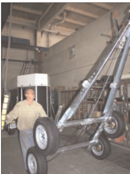
Die Montage und Reparatur von Anhängern gehört zum Leistungsprofil von HKM.
