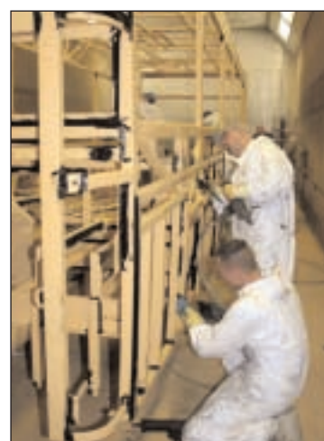
Enrico Berwing (vorn) und Micha Grade beim Abdichten der Schweißnäthe.
