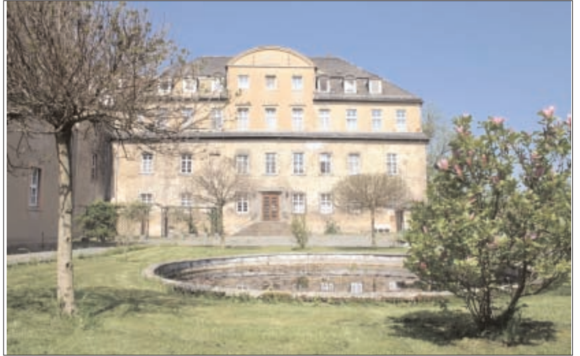
Ansicht des Stift-Gebäudes von der Hofseite aus: Der Stift wird erhalten und saniert. Die oberste Etage wird abgetragen, um den originalgetreuen, denkmalgerechten Zustand von 1907 herzustellen. Foto: AG
