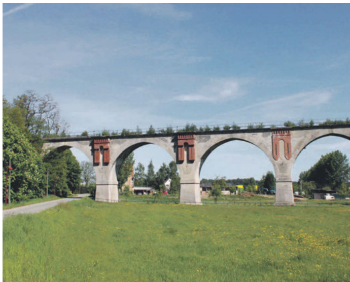
Das Viadukt Nirkendorf ist die erste der Eisenbahnbrücken im Wieratal, die für Fußgänger und Radfahrer freigegeben ist.
