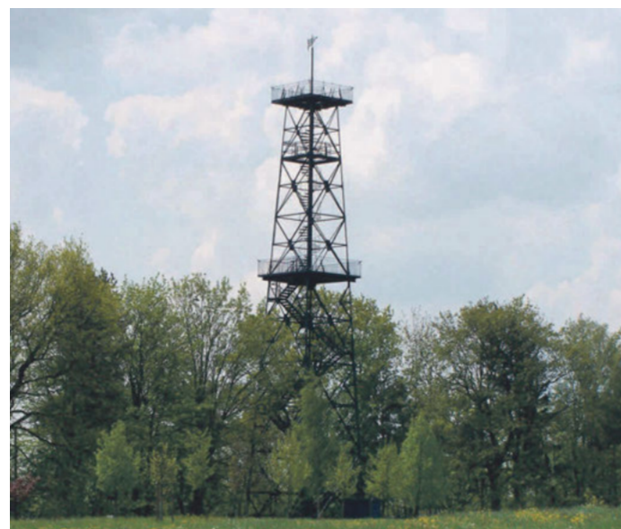
Von der Industrialisierung der Gründerjahre des ausgehenden 19. Jahrhunderts kündigt der Ernst-Agnes-Turm in Schmölln.
