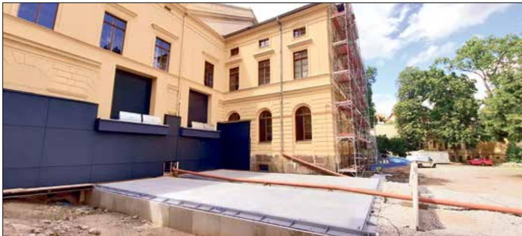
*Die beiden Fahrzeughebebühnen am Theater sind fertig eingebaut und können später Requisiten auf Bühnenhöhe transportieren.*
