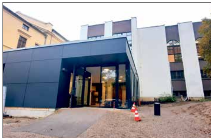
Ein komplett neuer Eingangsbereich empfängt nun die Gäste des Heizhauses.
