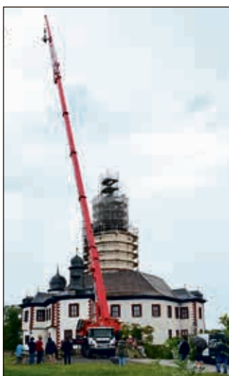
Per Kran wurden die neue Wetterfahne und die restaurierte Kuppel auf den Turm gehoben.
