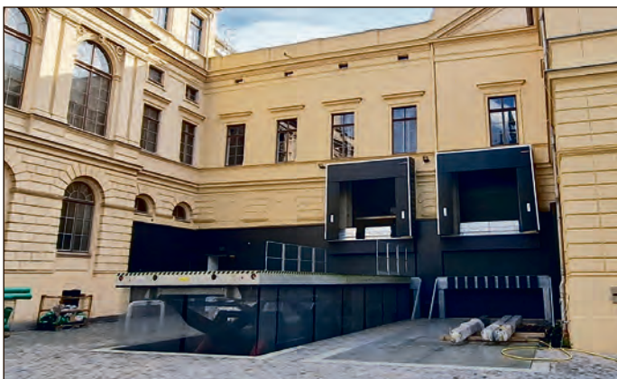
Lkw-Hebebühnen zur Anlieferung von Technik und Requisiten auf das Bühnenniveau von drei Metern. Daneben schließt sich im Inneren das Magazin mit dem neuen Paternosterregal an.
