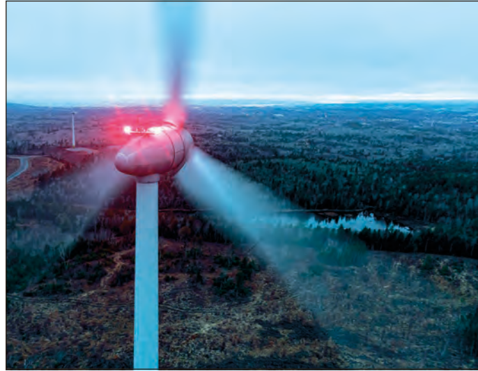
Nachtkennzeichnung der Windenergieanlagen. Foto: istock
