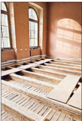
Die Decke im ersten Obergeschoss ist bis auf die Füllbodenschalung ausgebaut.
