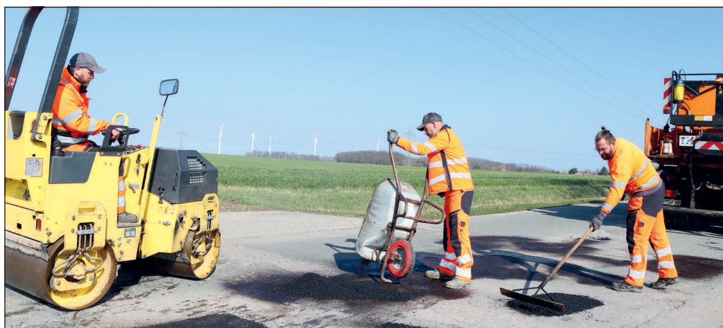
Mitarbeiter der Kreisstraßenmeisterei beim Ausbessern einer Kreisstraße.
