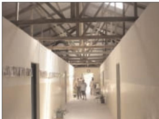
Blick ins Schulgebäude. Zwecks besserer Durchlüftung wurde auf eine Zwischendecke zum Dach verzichtet.
