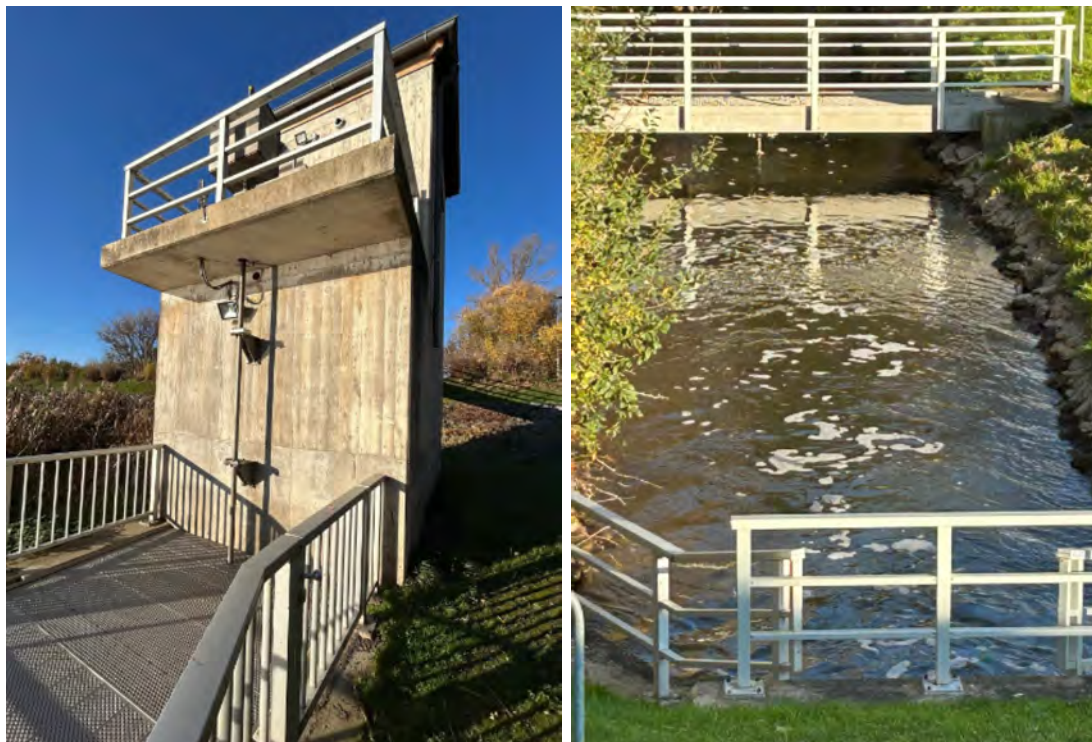
Abbildung 14 links: Talsperre Windischleuba: Grundablasselinlauf am Damm (Foto: R. Pohl)
