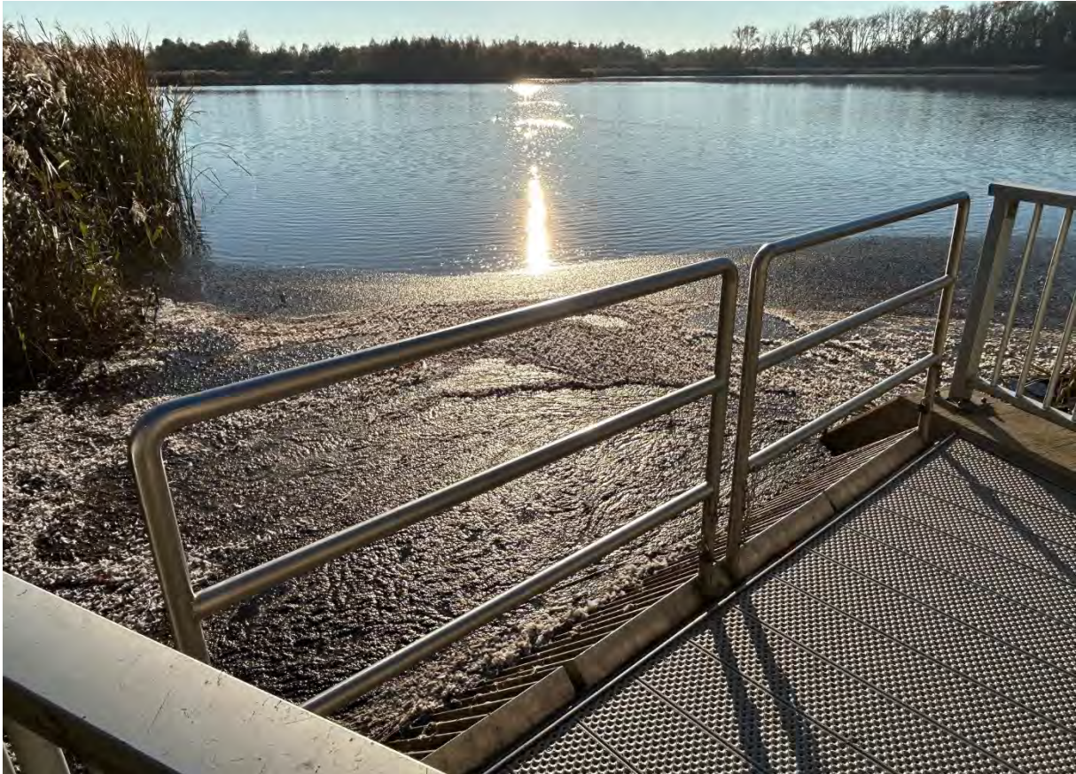
Abbildung 18 Talsperre Windischleuba: Blick vom Grundablassablauf auf den Stausee. Vor dem Grundablassseinlauf sammelt sich Schaum (Foto: R. Pohl)
