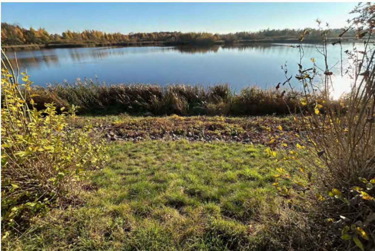
Abbildung 11 Talsperre Windischleuba: Blick vom Staudamm auf den verbliebenen Stausee bei Vollstau (Foto: R. Pohl 2025)
