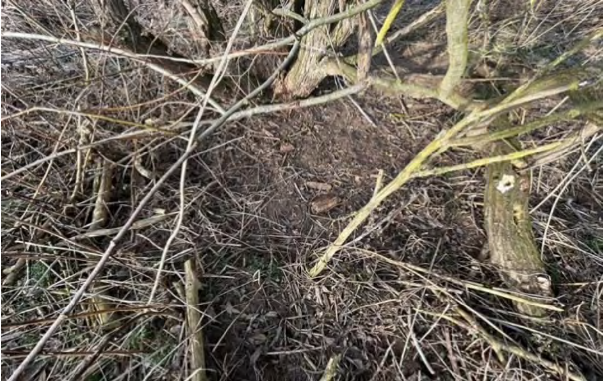
Abbildung 30 Talsperre Windischleuba: Sediment im Stauraum (Foto: Pohl 2026)
