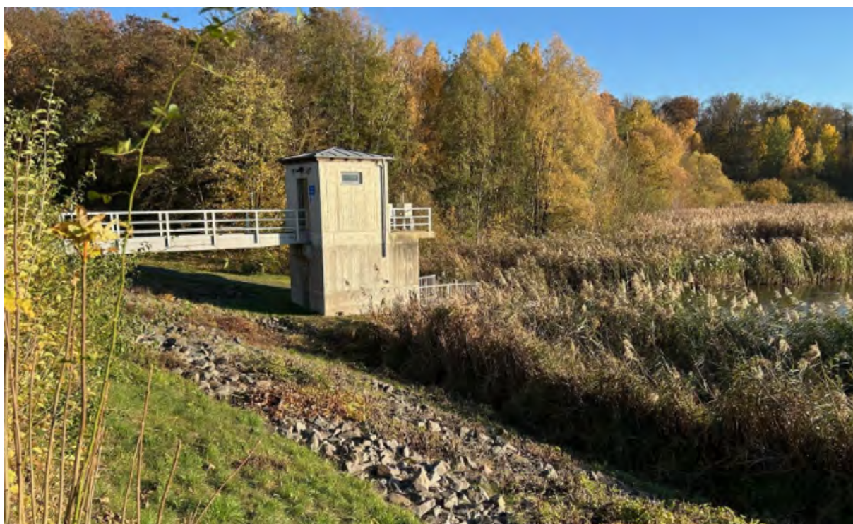
Abbildung 8 Talsperre Windischleuba: Blick von der Staudammkrone zum Grundablass-/Betriebsauslass-Einlauf (Foto: R. Pohl 2025)
