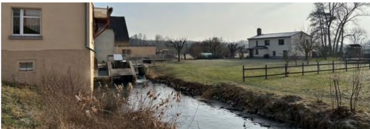
Abbildung 4 Talsperre Windischleuba: Mühlgraben und Mühle Fockendorf (Foto R. Pohl 2025)
