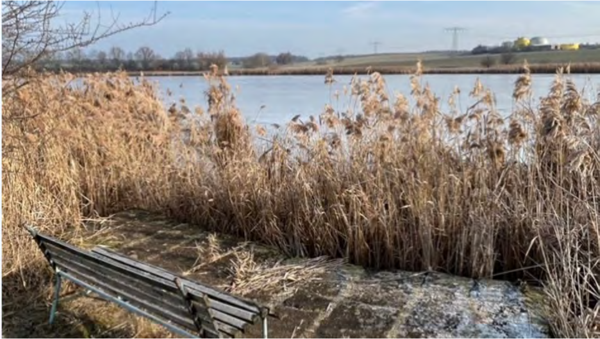
Abbildung 25 Talsperre Windischleuba: Windischleuba dichter Bewuchs und Sediment im Stauraum rechtes Vorbecken (Foto: Pohl 2026)
