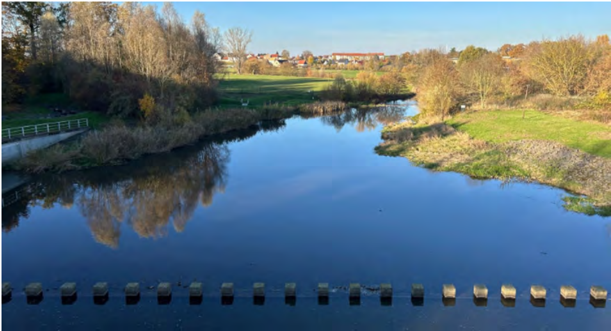
Abbildung 2 Talsperre Windischleuba: Pleiße im Unterwasserbereich, Tosbecken mit Zahnschwelle, Fischtreppe links, Ortschaft Fockendorf hinten (Foto R. Pohl 2025)
