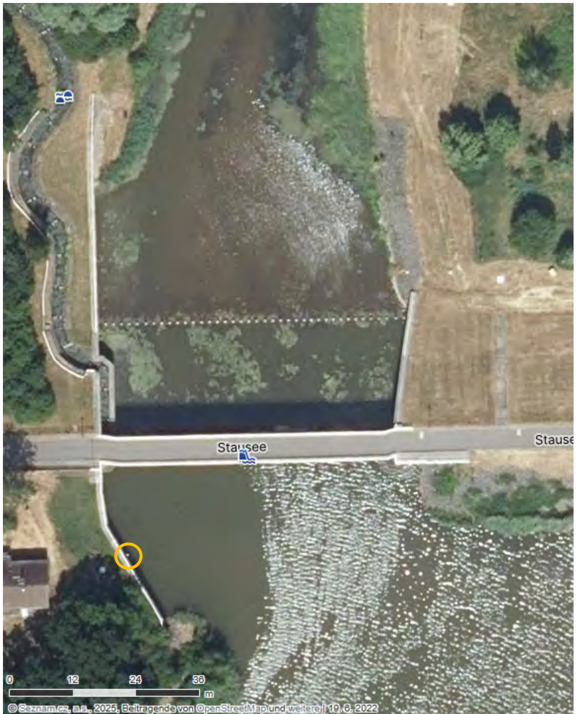
Abbildung 21 Staudammabschnitt mit der Hochwasserentlastungsanlage/Überfallschwelle mit Tosbecken, Fischpass und Zahnschwelle im Luftbild. Links an der Flügelmauer der automatische Beckenpegel (mapy.com 11/2025)
