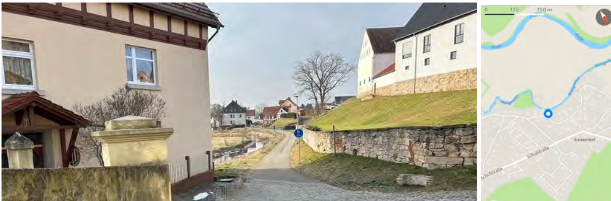
Abbildung 3 Talsperre Windischleuba: Unterwasserbereich Mühlgraben Fockendorf hinten (Foto R. Pohl 2025)
