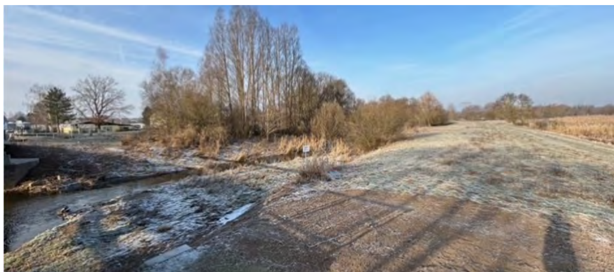
Abbildung 24 Talsperre Windischleuba: südlicher Stauraum Stauwurzel (Foto: Pohl 2026)
