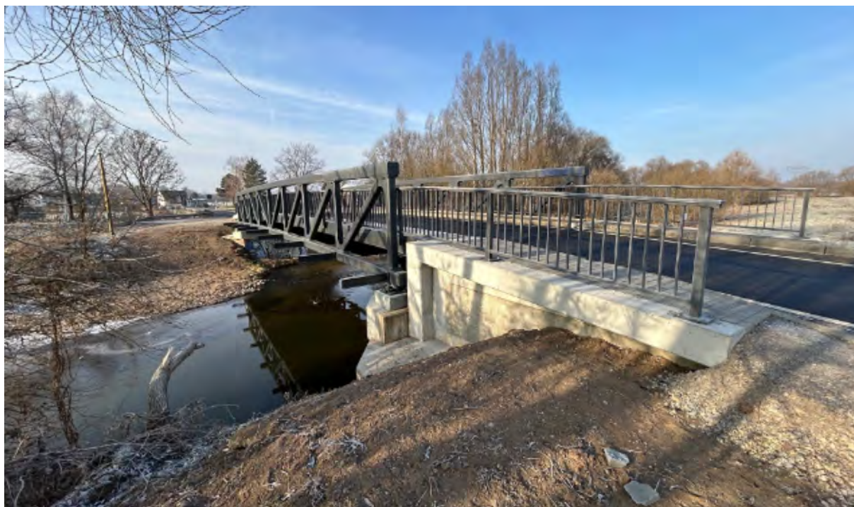
Abbildung 23 Talsperre Windischleuba: Einspurige Behelfsbrücke der B7 über die Pleiße an der Stauwurzel (Foto: Pohl 2026)
