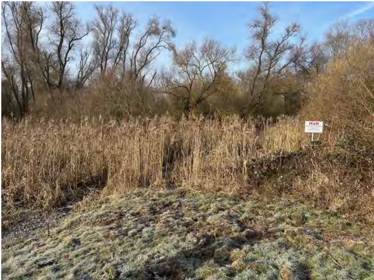
Abbildung 5 Talsperre Windischleuba: dichter Bewuchs und Sediment im trocken liegenden Hauptstauraum am Dammweg (zwischen linkem Vorbecken und dem Hauptbecken) von Pähnitz nach Borgishain (Foto: Pohl 2026)
