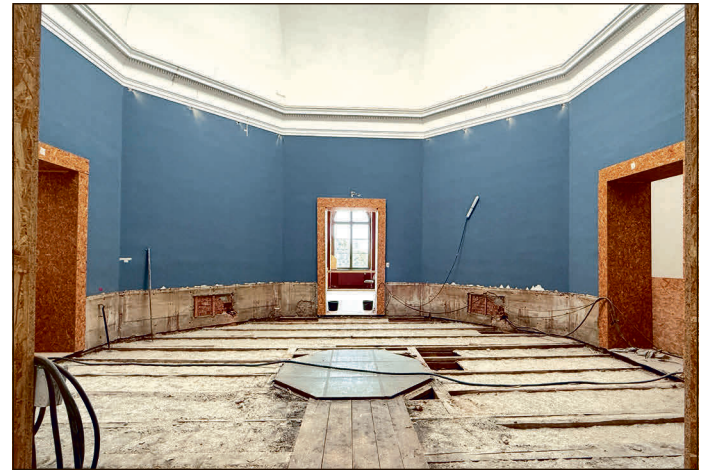
Das Parkett im 2. Obergeschoss wurde entfernt.
