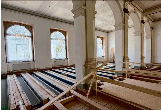
Die Verstärkung der Decken im 1. Obergeschoss.
