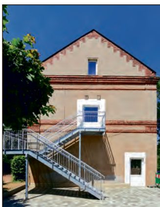
Grundschule Thonhausen: Neue Fluchttreppe mit -tür.
