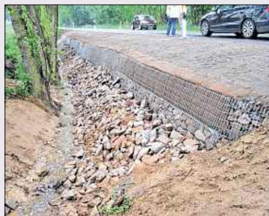
Das Foto links zeigt den Böschungsrutsch an der K 603 zwischen den Abzweigen Dobraschütz und Kraasa nach dem Hochwasser im Juni 2013. Rechts ist die Böschung nach der Sanierung im Juli 2014 zu sehen.
