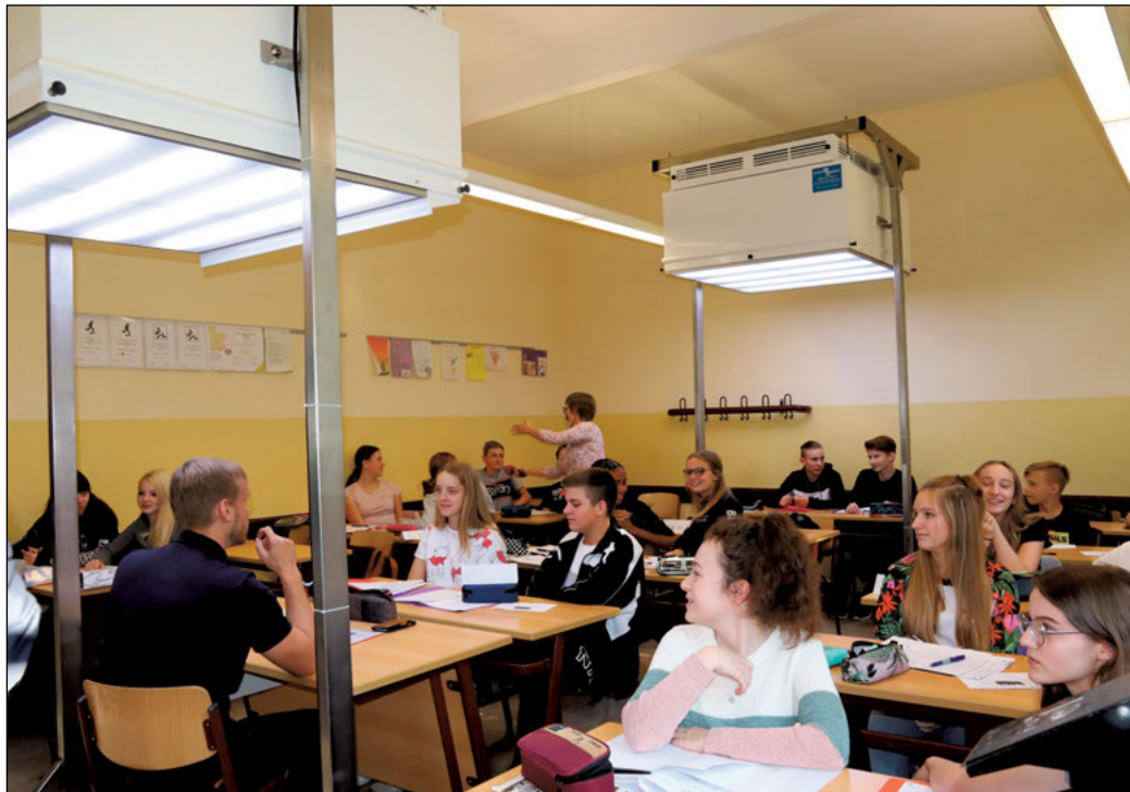
Die Luftreinigungsgeräte „Virusfrei 1200“ sind an Gestellen über den Schülern montiert.
